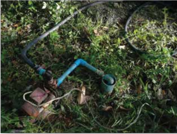
ภาพที่ 1 ปุ่มสูบน้ำบาดาล
